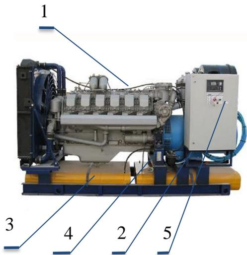
**1)Дизельный двигатель** - 12-ти цилиндровый с V-образным расположением цилиндров, водовоздушным охлаждением и регулятором частоты вращения;
